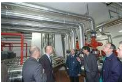
impianto di teleriscaldamento
