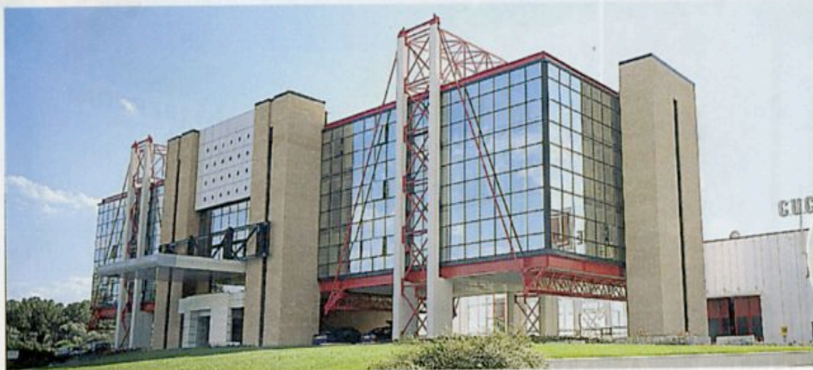
La nuova palazzina della Lube, di Giuliano Sileoni (sotto)
